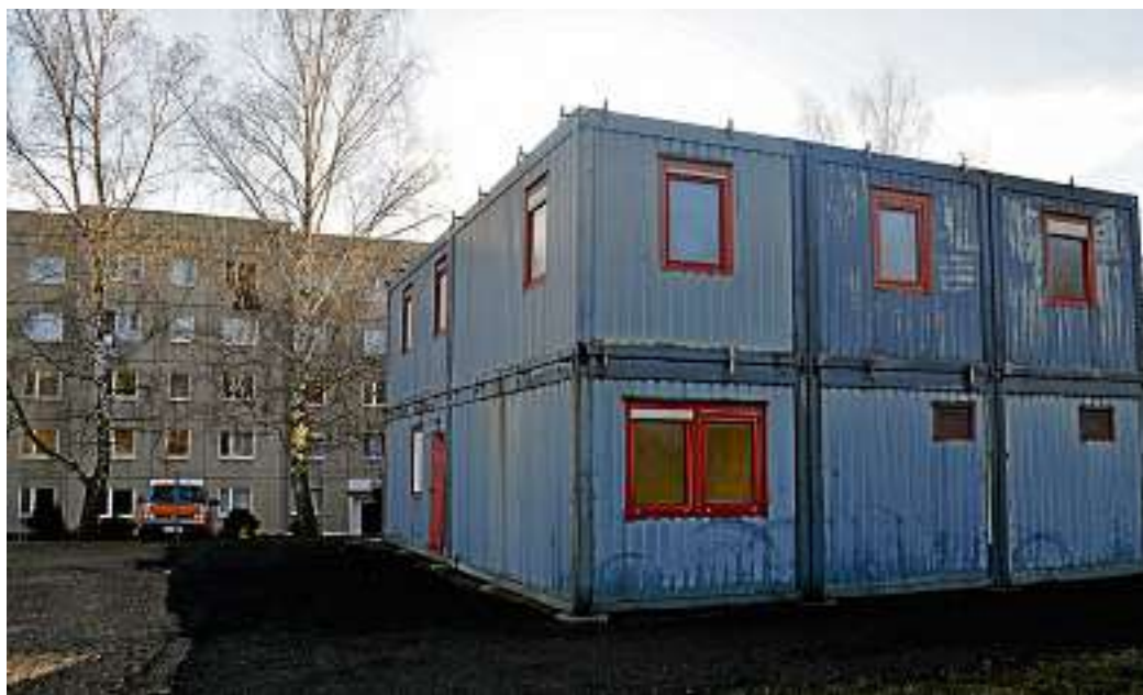
Hinter der Flüchtlingsunterkunft an der Ettersburger Straße sind erste Wohncontainer aufgebaut worden. Sie sollen 30 bis 40 Menschen Platz bieten. Foto: Christian Voigt
