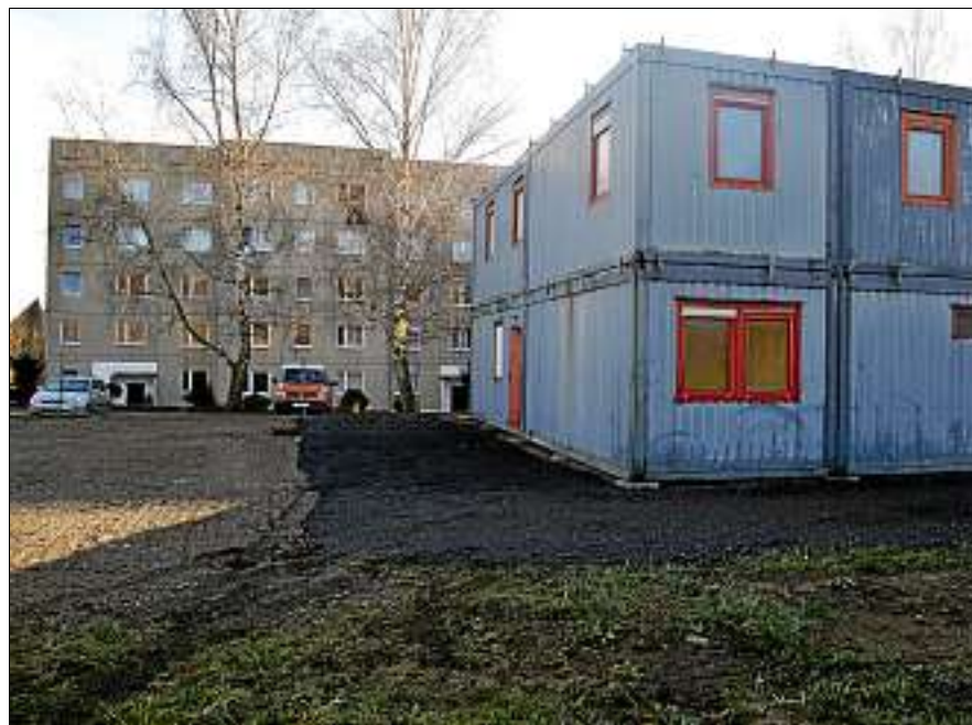
Neben der Flüchtlingsunterkunft an der Ettersburger Straße werden Wohncontainer aufgebaut. Sie sollen Platz für 30 bis 40 Menschen bieten. Foto: Christian Voigt
